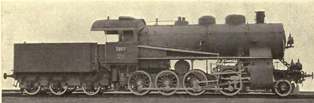
FOUR-CYLINDER, SUPERHEATED, COMPOUND (2—8—0 TYPE) GOODS' LOCOMOTIVE,
